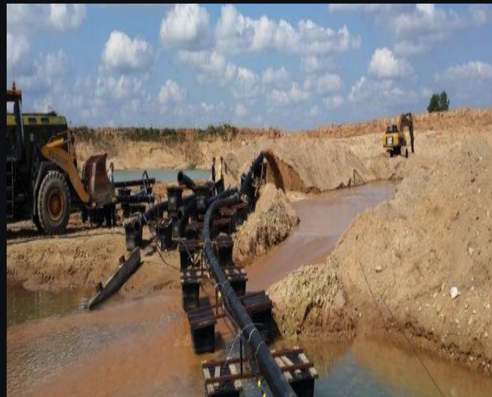
Работа земснаряда · пульпопровод
